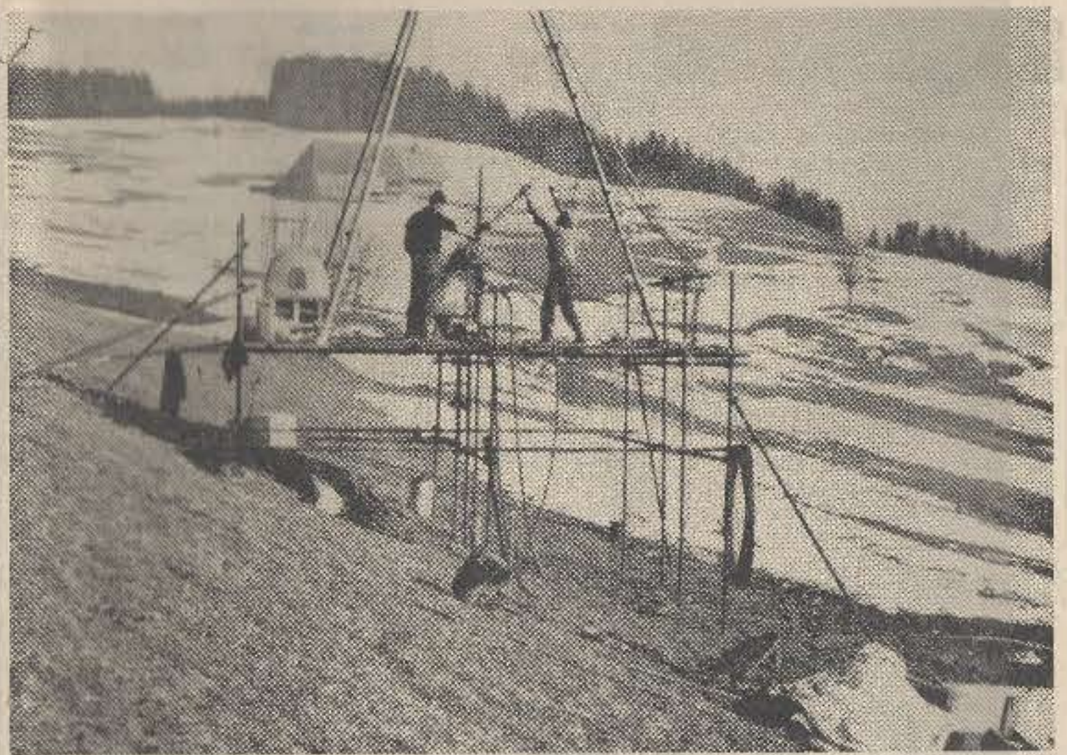
Kernbohrung nach uranhaltiger Kohle im Blaphachgebiet
