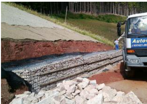
Sanierungsmaßnahme an einem Altstandort des Uranbergbaus.
