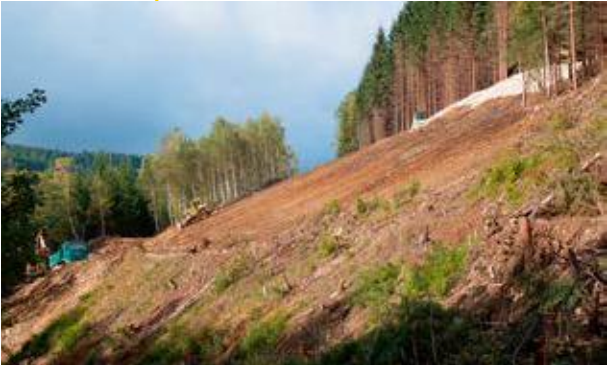
Sanierung einer Halde des ehemaligen Uranerzbergbaus
